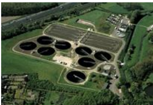
Figuur 7. Luchtopname RWZI. Bovenin zijn de langwerpige beluchters te zien. Hier wordt het afvalwater rondgepompt en van Zuurstof voorzien. Daaronder de ronde bekkens waar het water kan bezinken en het water met behulp van een ronddraaiende hark van vuil ontdaan wordt.
