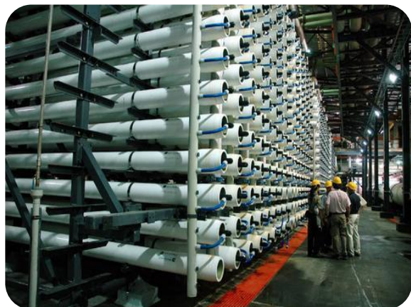
Grootschalige omgekeerde osmose installatie voor de productie van drinkwater.
