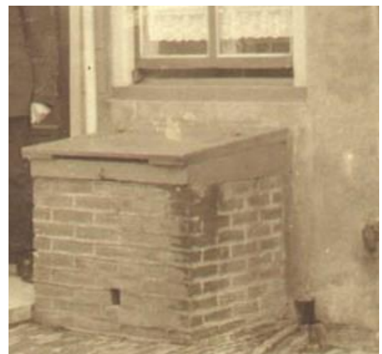
Regenwaterverzamelbak op een van de Zeeuwse eilanden. De pomp hangt boven het keukenaanrecht direct achter het raam. Zie overloopgat en goot voor gebruikt water naar de straat
