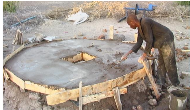
Klaar voor het plaatsen van de touwpomp
