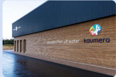
Kaamera extraction plant Zutphen Picture: Waterschap Rijn en IJssel
